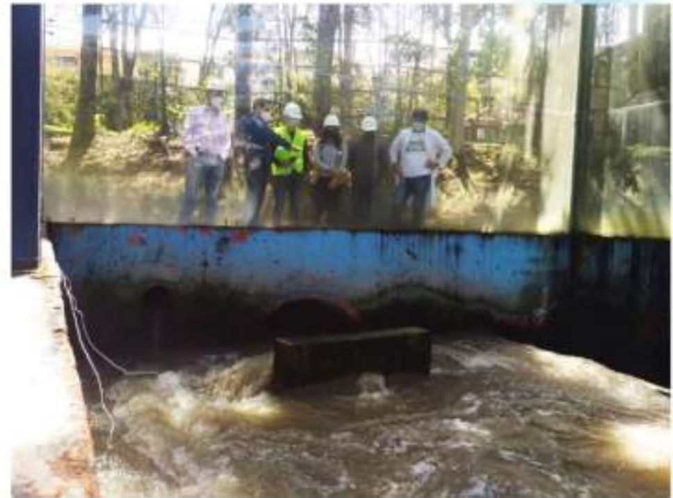
Visita técnica a la PTAR de Ucubamba, Cuenca
